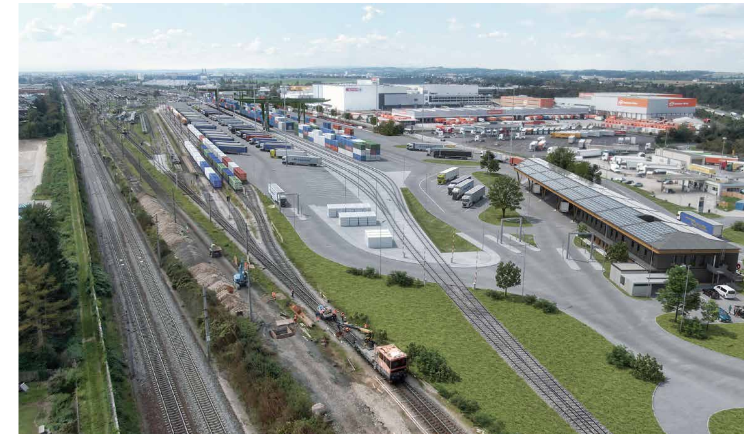
Quantensprung für den Terminal Wels: Die Verlängerung und ostseitige Verknüpfung der Gleise der Kranbahn mit der Weststrecke schaffen ein hocheffizientes Durchfahr-Terminal.
