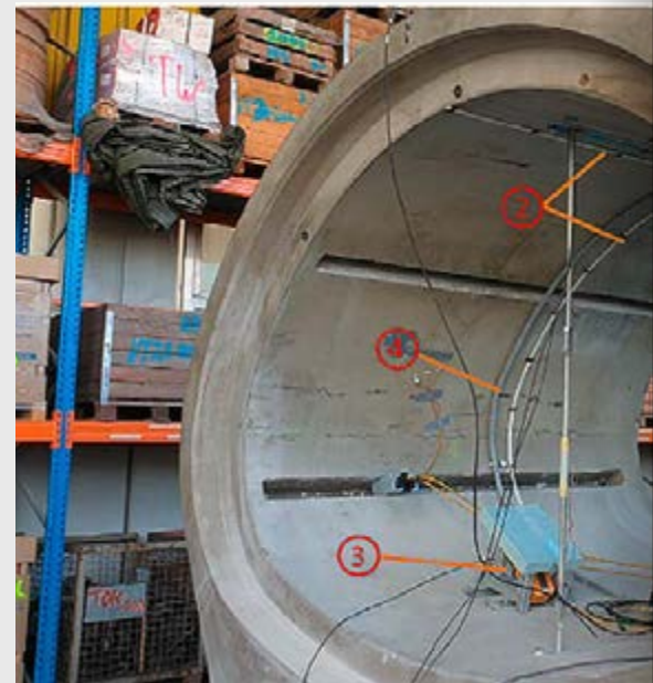
ROHRQUERSCHNITT. Monitoringsysteme für die Sensor, (3) Laserdistanzsensor, (4) SAA-Inklinometer
