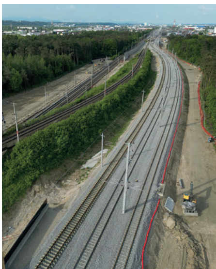
Ende Juni geht der Bypass in Marchtrenk in Betrieb, damit die Züge auch während dem Bau fahren können.
