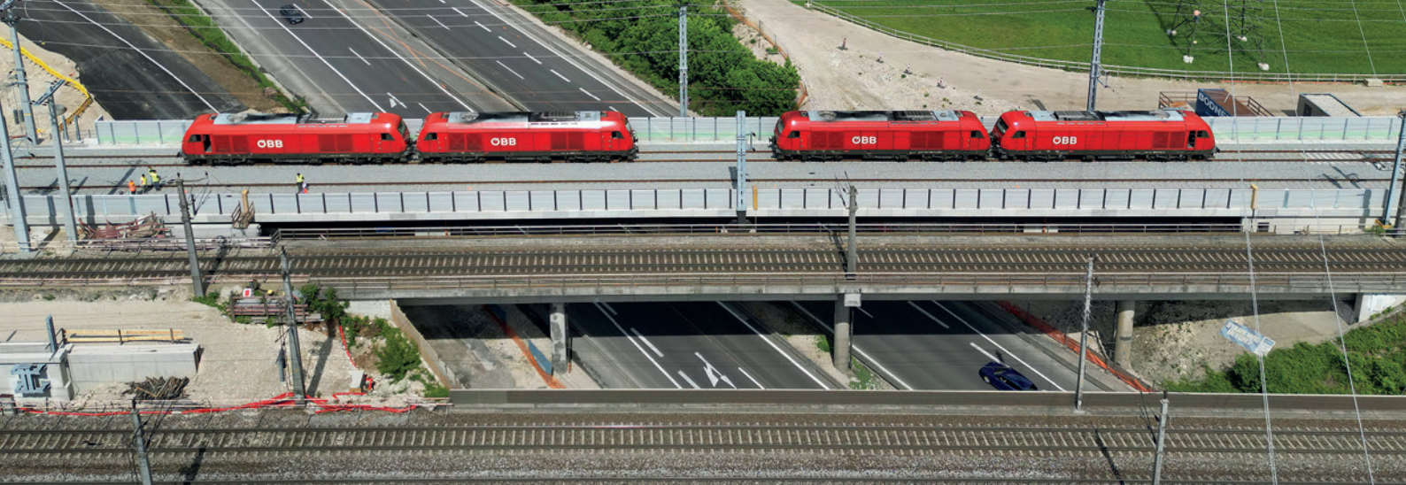
Belastungstest der ersten neuen Brücke über die A25
