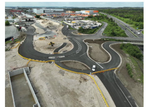
Der neue Zufahrtsbereich beim Terminal ist fertig.
