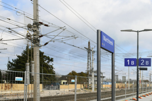
Der neue Bahnsteig 2 ist bereits in Betrieb.
