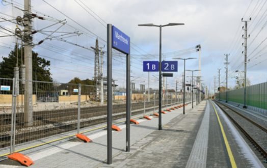
Der neue Bahnsteig 2 ist bereits in Betrieb.
