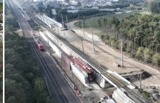
Nach und nach entsteht das neue Überwerksbauwerk zwischen dem Bahnhof Marchtrenk und der Brücke über die A25. © ICM/Winkler
