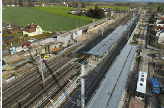
In Bau: Der nördliche Zugang zum Personendurchgang und zum neuen Bahnsteig.
