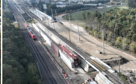
Nach und nach entsteht das neue Überführungsbauwerk zwischen dem Bahnhof Marchtrenk und der Brücke über die A25. © ICM/Winkler
