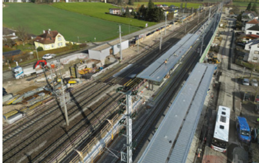
In Bau: Der nördliche Zugang zum Personendurchgang und zum neuen Bahnsteig.
