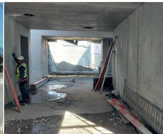
Aktuell wird der erste Teilabschnitt des Personentunnels fertiggestellt.
