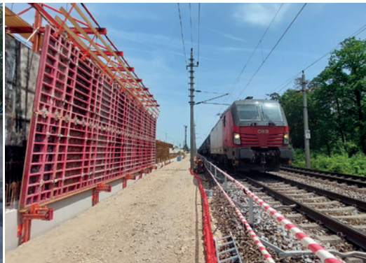
Marchtrenk: Herstellung Stützmauer im Bereich des neuen Überwerfungsbauwerks
