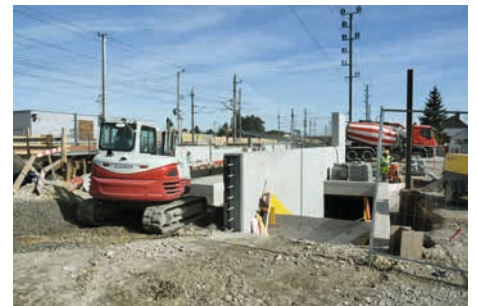
Der südliche Zugang zum Personendurchgang soll mit Ende 2023 in Betrieb gehen.
