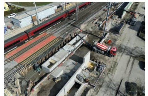
Unter den Hilfsbrücken (rot/gelbe Teile im Gleisbereich) wurde der Personendurchgang errichtet.
