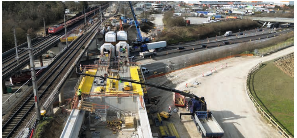
Der Rohbau der ersten Brücke wird bis Ende September fertiggestellt.
