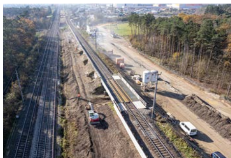
Das neue Überwerfungsbauwerk – hier werden demnächst Bohrpfähle errichtet
