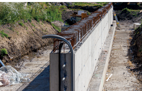
Stützmauer „Am Bahndamm“ als Fundament für die neue Lärmschutzwand
