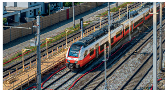
Bahnsteig 22 ermöglicht zwischenzeitlich den Zustieg zur Bahn
