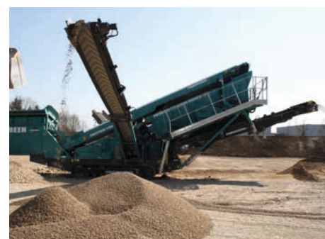
Recycling – Aushubmaterial wird für den Wiedereinbau aufbereitet
