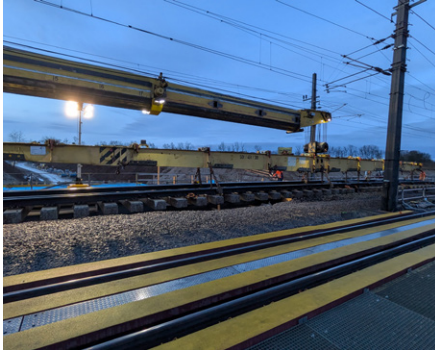
Gleise über neues Tragwerk Paschingerstraße
