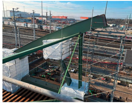
Vormontage der Bogenbrücke abseits der Trasse
