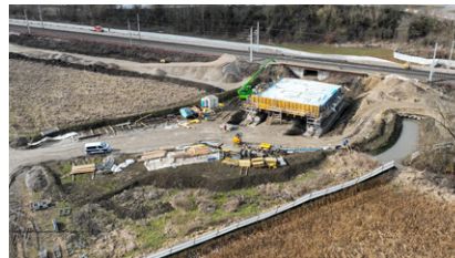
Errichtung Wildtierdurchlass in seitlicher Lage
