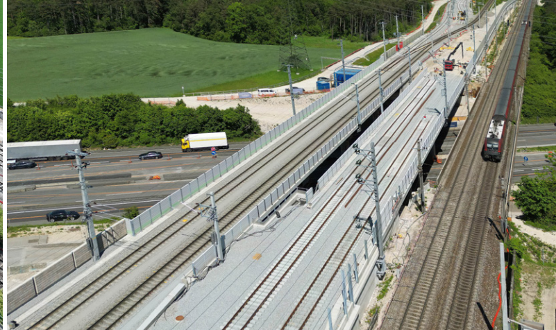
Gleisarbeiten auf der Brücke
