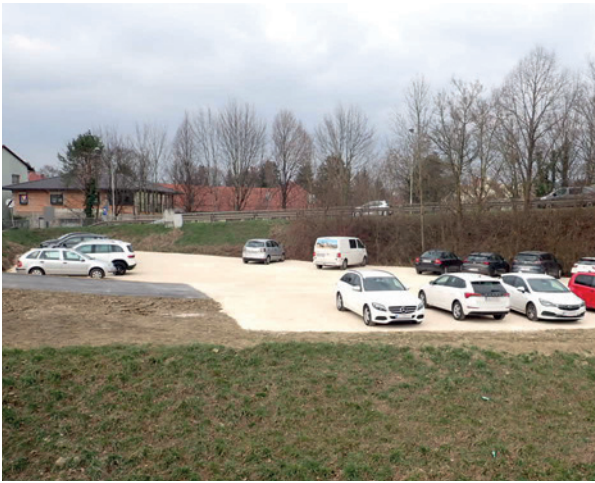
Park- und Ride-Anlage am Bahnhof Leonding
