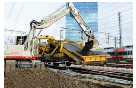
Material recyceln wir vor Ort oder transportieren es auf der Schiene ab.
