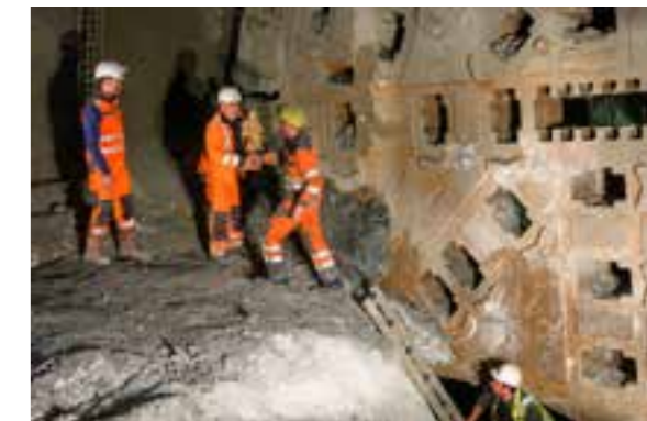
Der erste Durchschlag, Göstritz trifft Fröschnitzgraben
