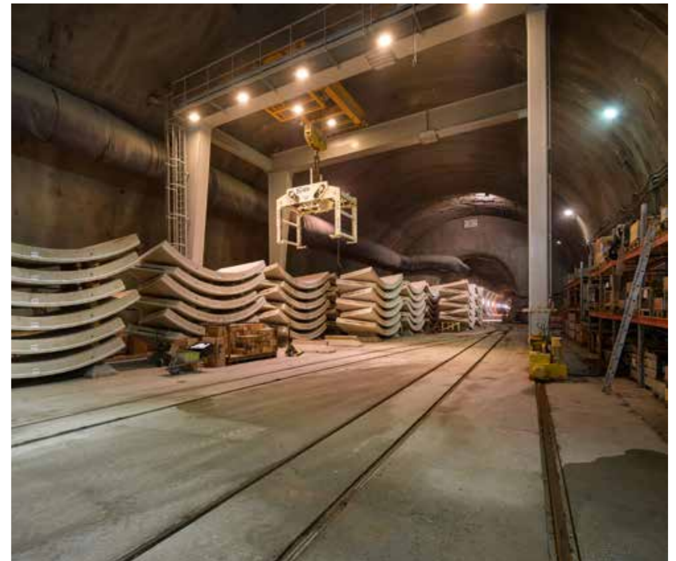
Die Nothaltestelle im Bereich Fröschnitzgraben im Bau
