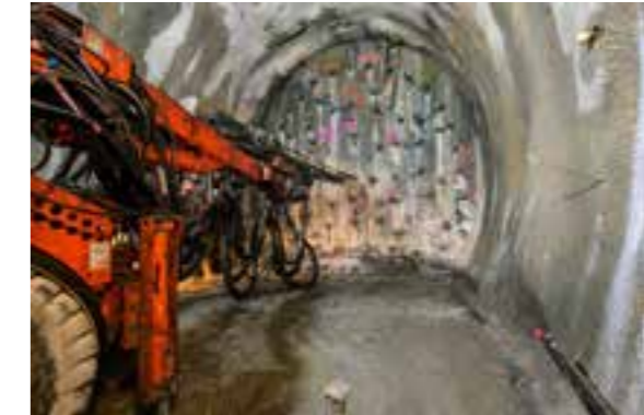
Sondermaßnahmen im Abschnitt Gloggnitz
