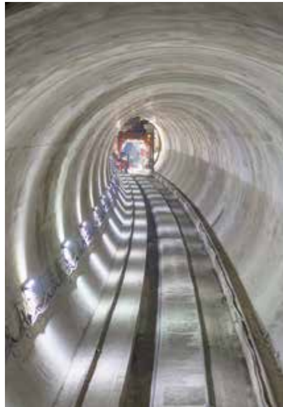
Teile der Tunnelinnenschale sind bereits errichtet
