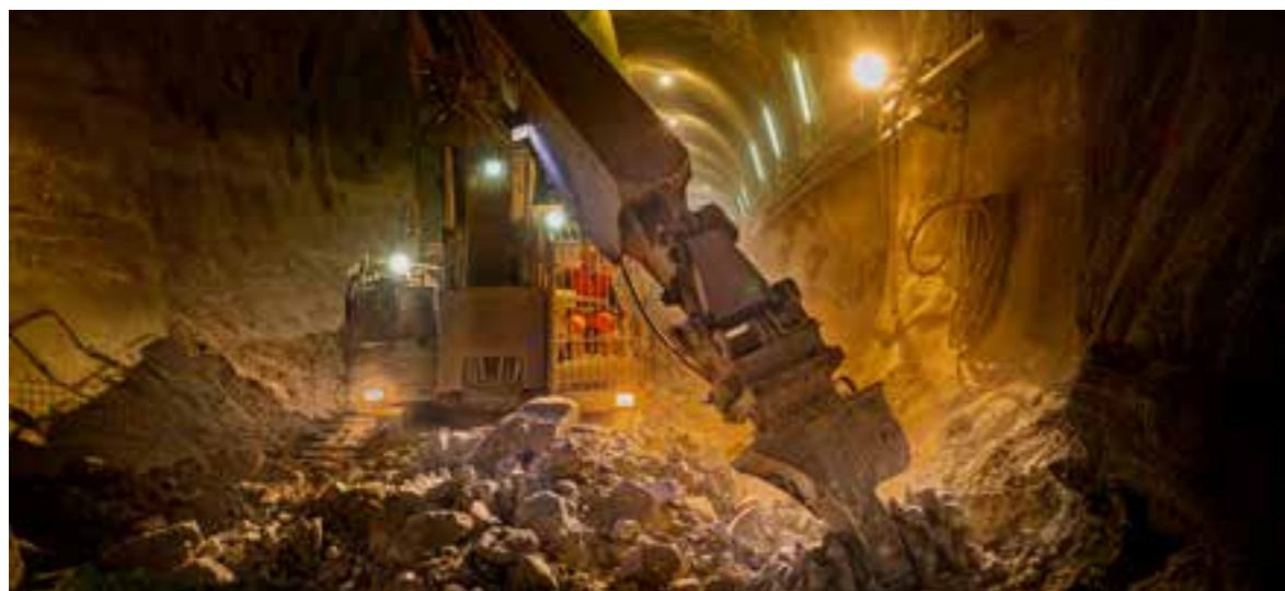
Ein großer Teil des Tunnels wird im Bagger- und Sprengvortrieb errichtet
