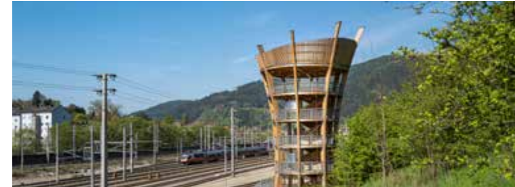
Am Infoturm in Mürzzuschlag hat man einen großartigen Überblick über die Baustelle
