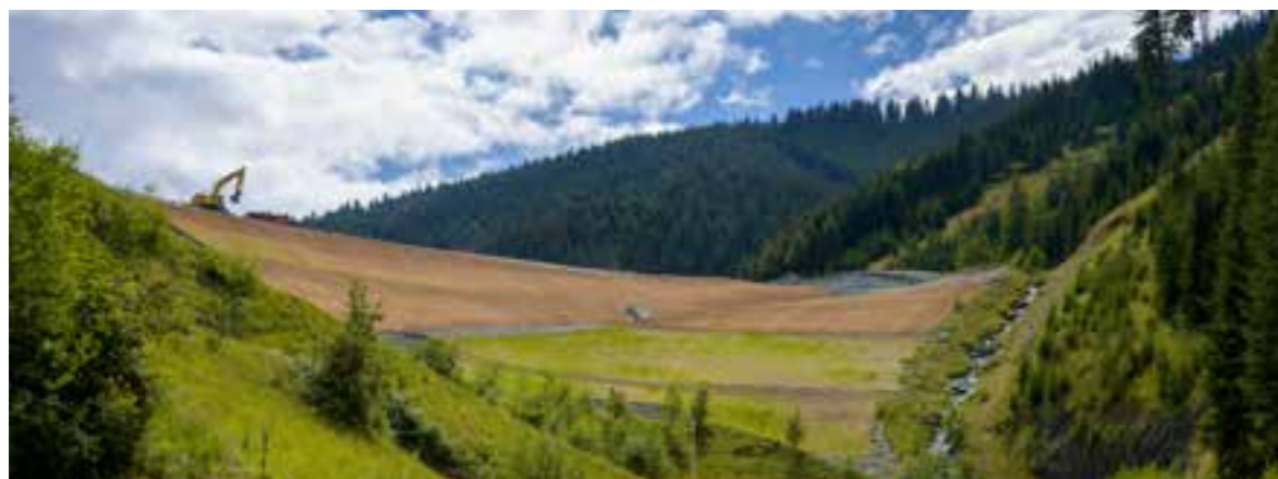
Die komplett befüllte Deponie Longsgraben im Herbst 2022
