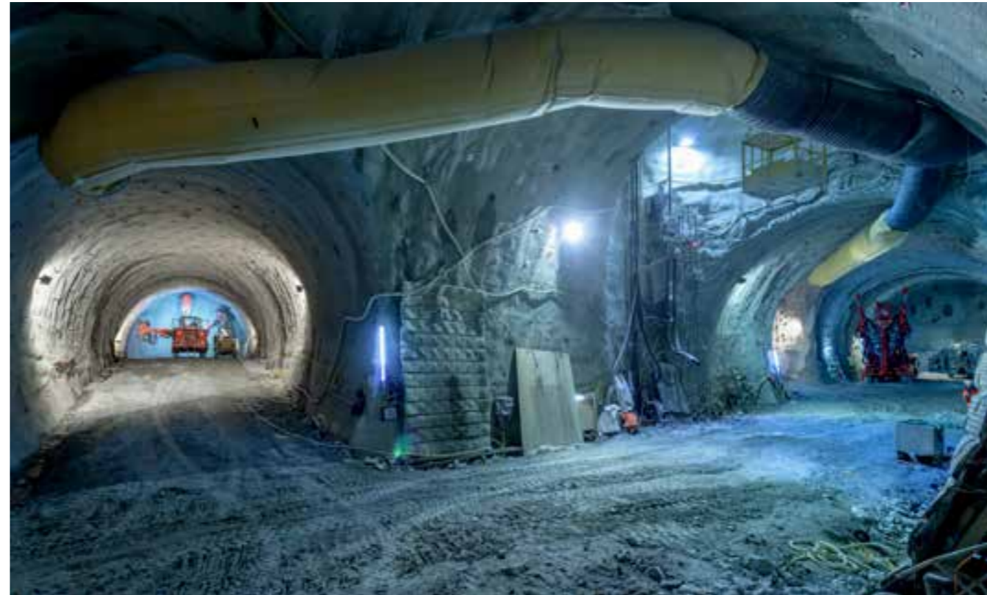
In bis zu 400 Meter Tiefe arbeiten sich die Mineure durch den Berg
