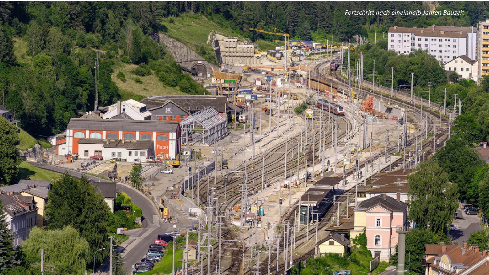
Gleisbereich vor Beginn der Arbeiten
