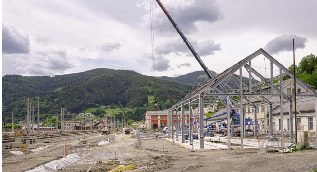
Die neue Gleishalle wird mit ihrer Holzfassade auch ein architektonisches Highlight.
