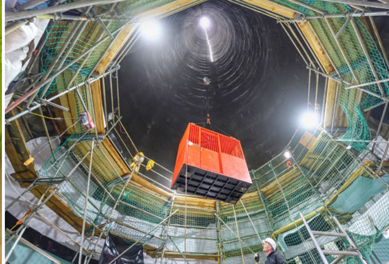
Arbeiten an den Lüftungsschächten
