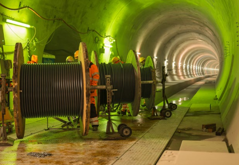
1.000 km Kabel werden im Tunnel verlegt
