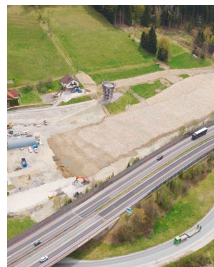
Die Baustelle in Grautschenhof ist rückgebaut
