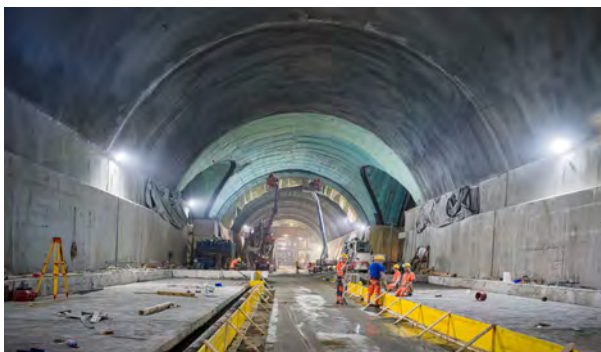
Arbeiten in der Nothaltestelle im Abschnitt Fröschnitzgraben
