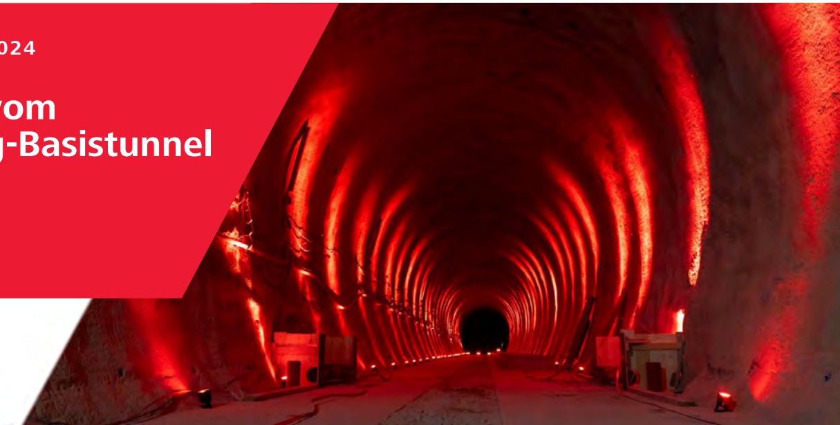
Lichteffekte bei der Show-Sprengung im Zuge der Tunnelführungen beim Infobaustellentag
