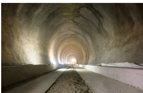
Der Tunnelabschnitt Grautschendorf
