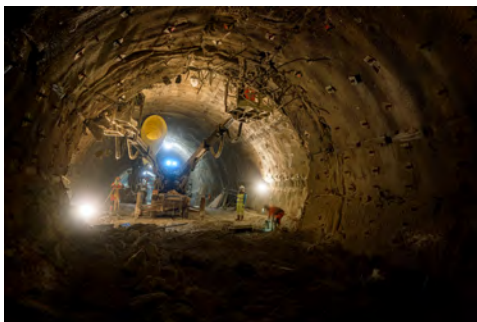
Arbeiten im Abschnitt Göstritz
