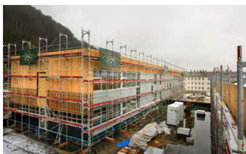
Der Instandhaltungs-Stützpunkt Gloggnitz
