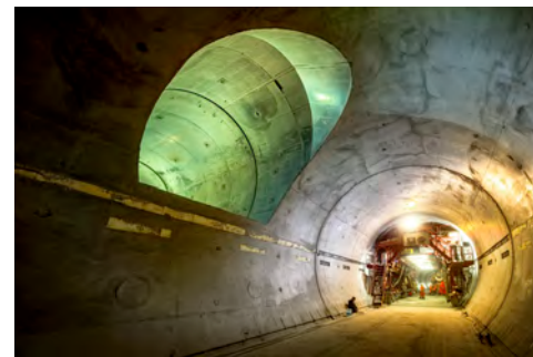
Tunnelabschnitt im Bereich Fröschnitzgraben
