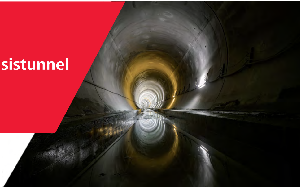
Fertige Tunnel-Innenschale im Abschnitt Fröschnitzgraben
