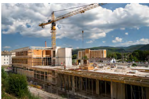
Arbeiten am Instandhaltungs-Stützpunkt Gloggnitz
