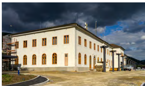
Die neue Fassade des Bahnhofsgebäudes
