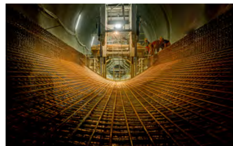
Bau der Innenschale in Grautschenhof beginnt
