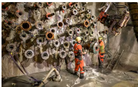
Injektionsmaßnahmen im Abschnitt Gloggnitz
