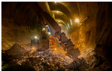
Tunnelvortrieb mit Bagger
