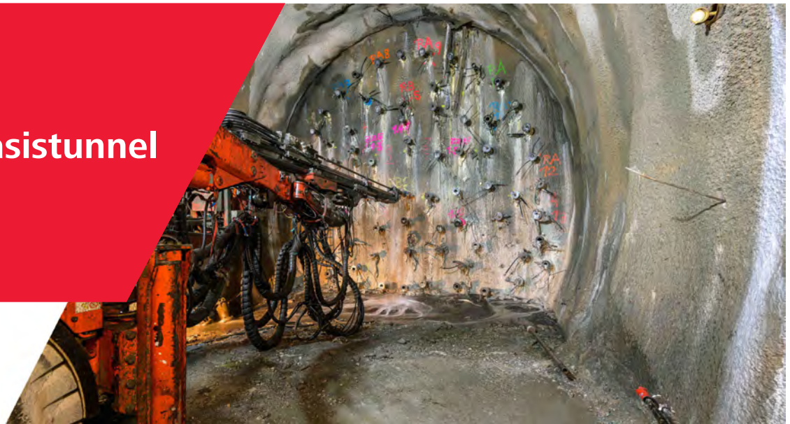
Sondermaßnahmen (Injektionen) im Bauabschnitt Gloggnitz
