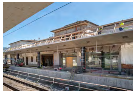
Arbeiten am Bahnhofgebäude Mürzzuschlag
