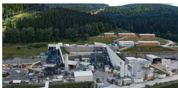
Blick auf die Baustelle im Fröschnitzgraben
