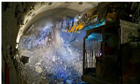
Bagger-Vortrieb im Bereich Göstritz
