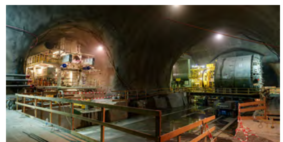
Die Montage der Tunnelbohrmaschine im Berg
