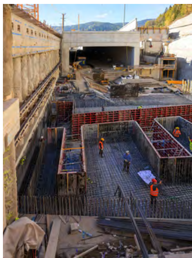
Blick auf den Portalbereich in Mürzzuschlag
