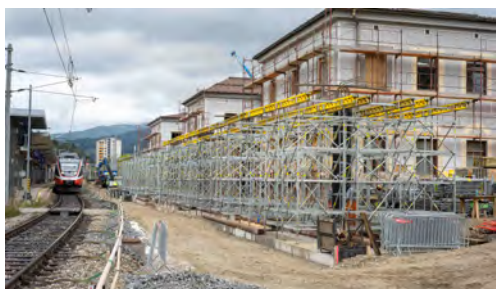
Arbeiten am Bahnhof Mürzzuschlag
