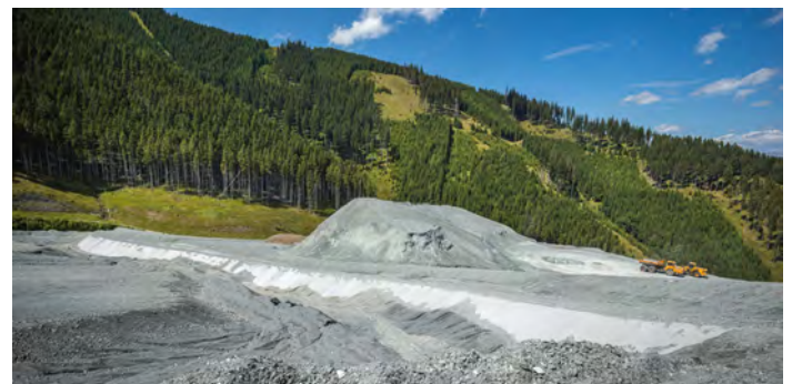
Die Deponie Longsgraben ist praktisch vollgefüllt
