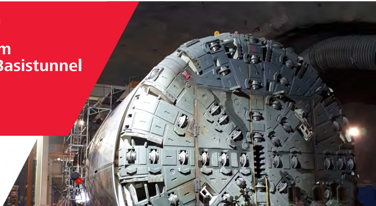
Die gewaltigen Tunnelbohrmaschinen haben zusammen fast 16 km zurück gelegt
