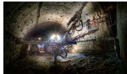
Anker werden gebohrt, um die Stabilität des Gebirges rund um den Tunnel zu erhöhen
