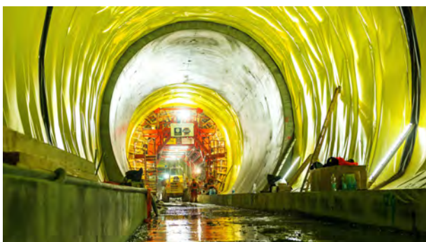
Bau der Innenschale in Fröschnitz mit Schalwagen im Hintergrund
