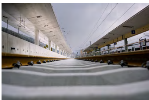
Neue Gleise am Bhf. Müzzzuschlag
