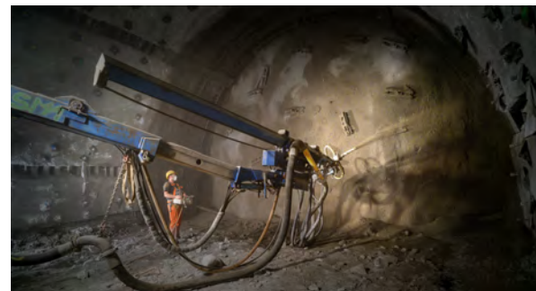
Spritzbeton-Arbeiten im Abschnitt Grautschenhof
