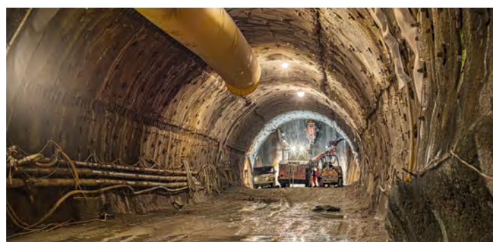
Herstellung von Speischirmen zur Sicherung des Tunnels in Gstritz
