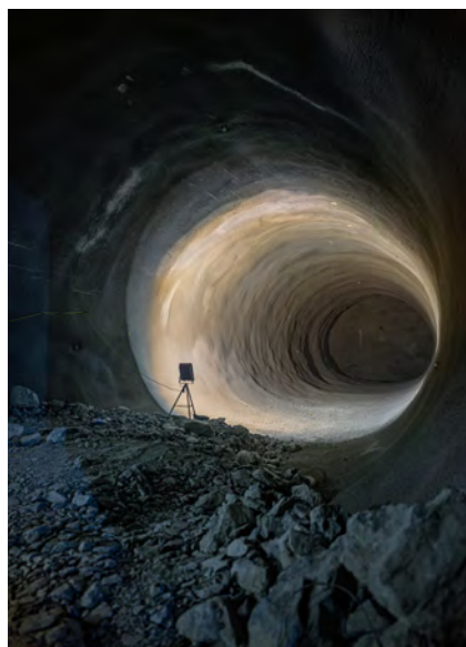
Ein Verbindungstunnel (Querschlag) im Bauabschnitt Fröschnitzgraben
