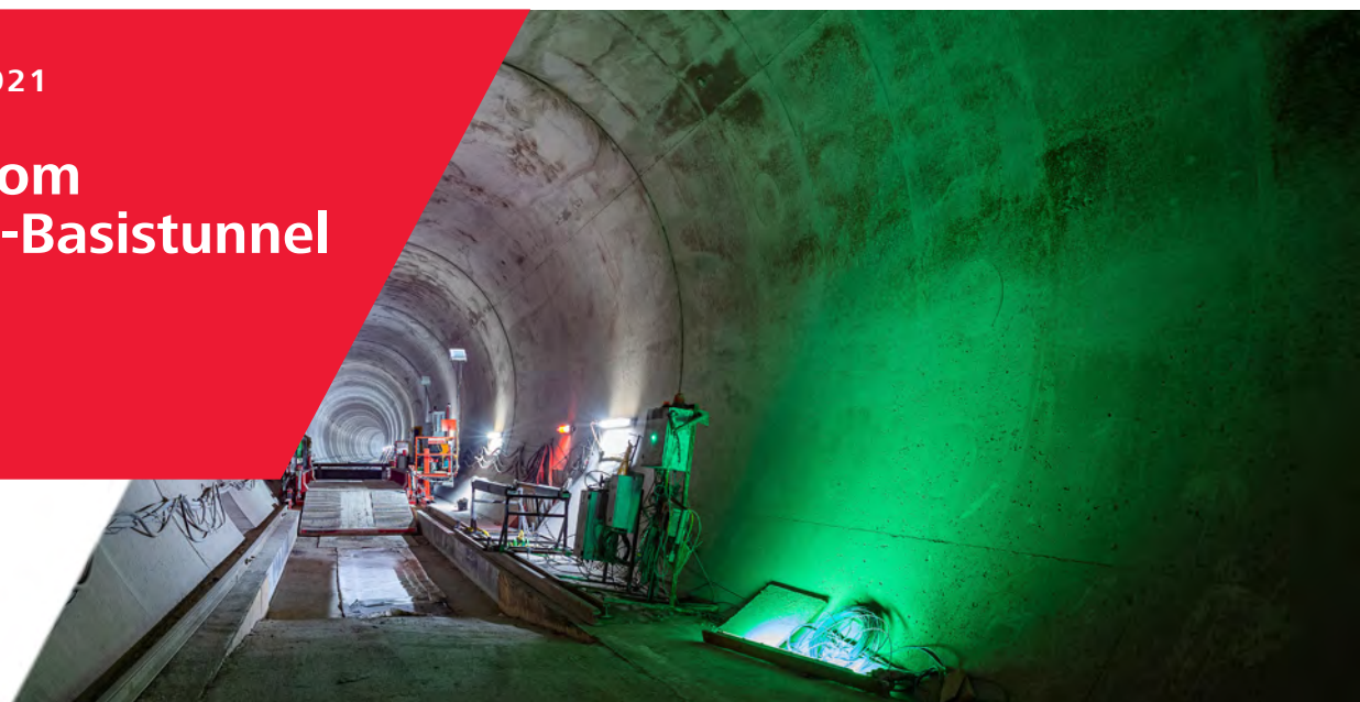
Innenschale des Tunnels im Bereich Gloggnitz
