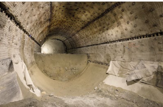
„Stachelemente“ in den Tunnelröhren Grautschenhof
