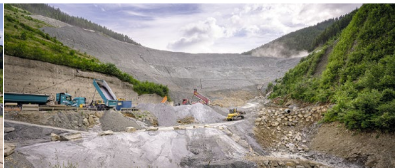
Deponie Longsgraben ist zu 85 Prozent befüllt.
