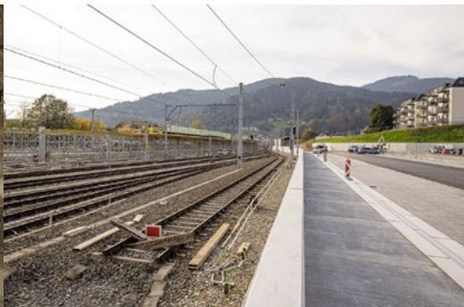
P&R-Anlage (rechts) und Bahnhofsdach (links) in Müzzzuschlag
