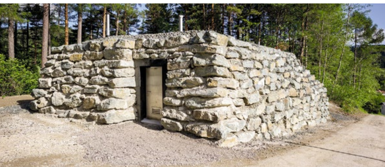
Hochbehälter Greis als Ersatztrinkwasserversorgung
