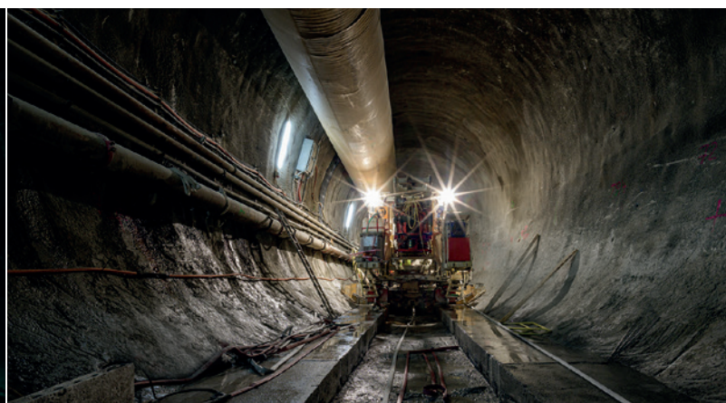
Auf der Baustelle Grautschenhof sind rund 1,6 Kilometer in vier Röhren gegraben.
