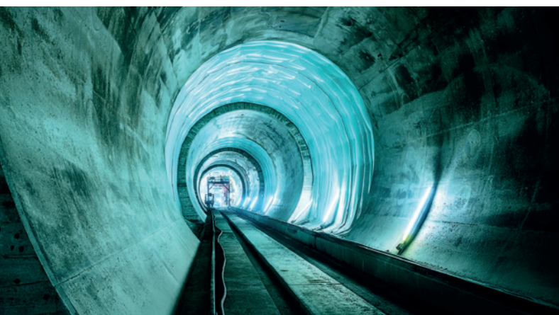
In Gloggnitz wird die Innenschale eingebaut.
