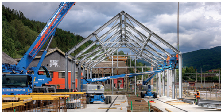
Die neue Gleishalle in Mürzzuschlag nimmt Formen an.
