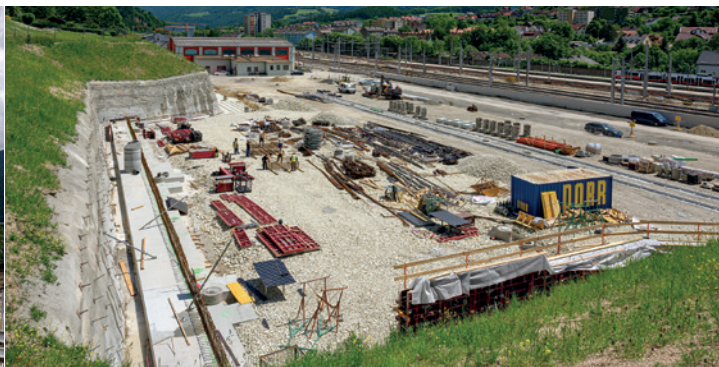
Der Bau der P&R-Anlage für 370 Stellplätze schreitet voran.
