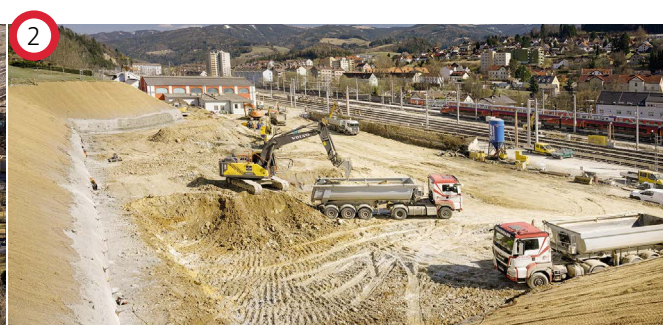
Der Bau der P&R-Anlage für 370 Stellplätze schreitet voran.
