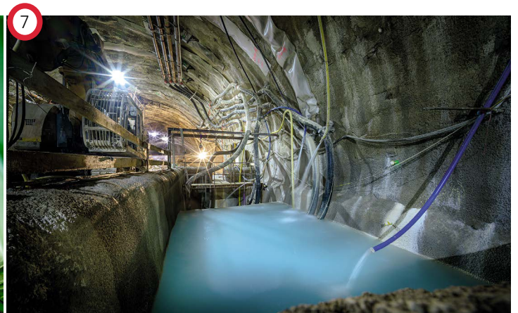
Das Wasser aus dem Tunnelbau bei Göstritz wird geordnet abgeleitet
