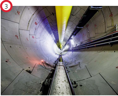
Beim Vortrieb mit Tunnelbohrmaschinen wird die Außenschale mit Betonfertigteilen („Tübbinge“) hergestellt.
