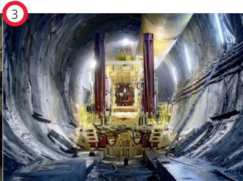
Betoneinbau in Grautschenhof
