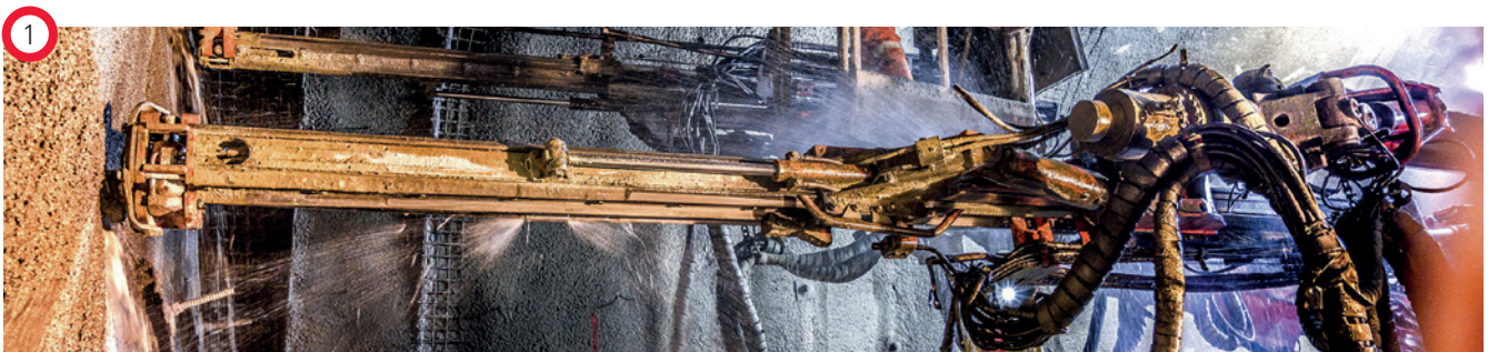
Bagger-Sprengvortrieb auf der Baustelle Fröschnitzgraben
