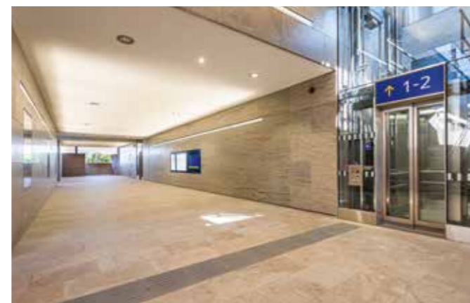
Personendurchgang am Bahnhof Münchendorf an der Pottendorfer Linie als Beispiel für die Gestaltung von neuen Bahnhöfen.
