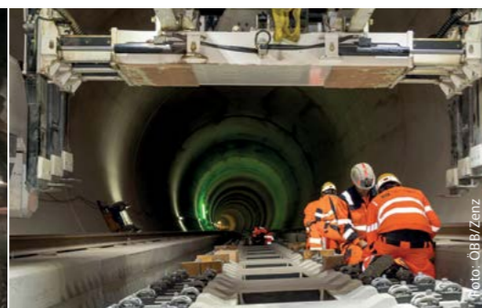
Montage der Gleistragplatten
