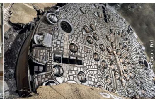
Megabohrer beim Durchschlag
