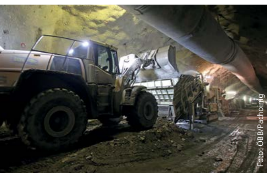
Zyklischer Vortrieb im Berg
