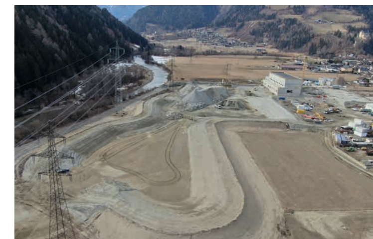
Damm für Ausgleichsbecken
