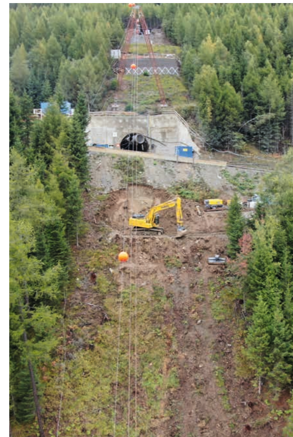
Kraftabstieg beim Portal Zufahrtstunnel
