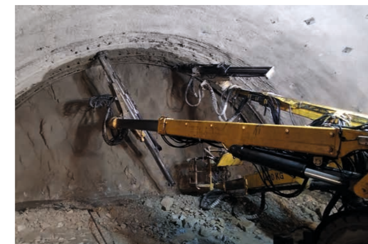
Sicherungsarbeiten im Speicherstollen
