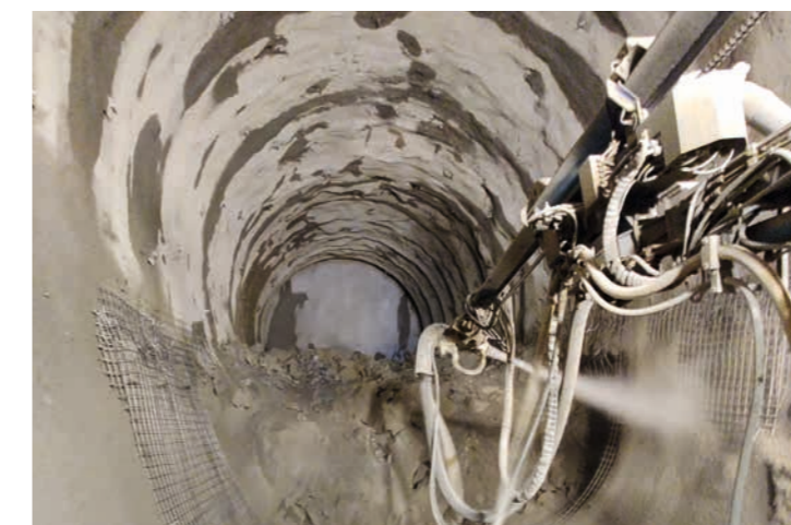
Zufahrtstunnel: Ausbruch der Sohle
