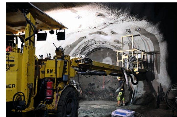
Arbeiten im Triebwasserstollen
