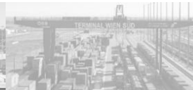
TERMINAL Wien Süd
