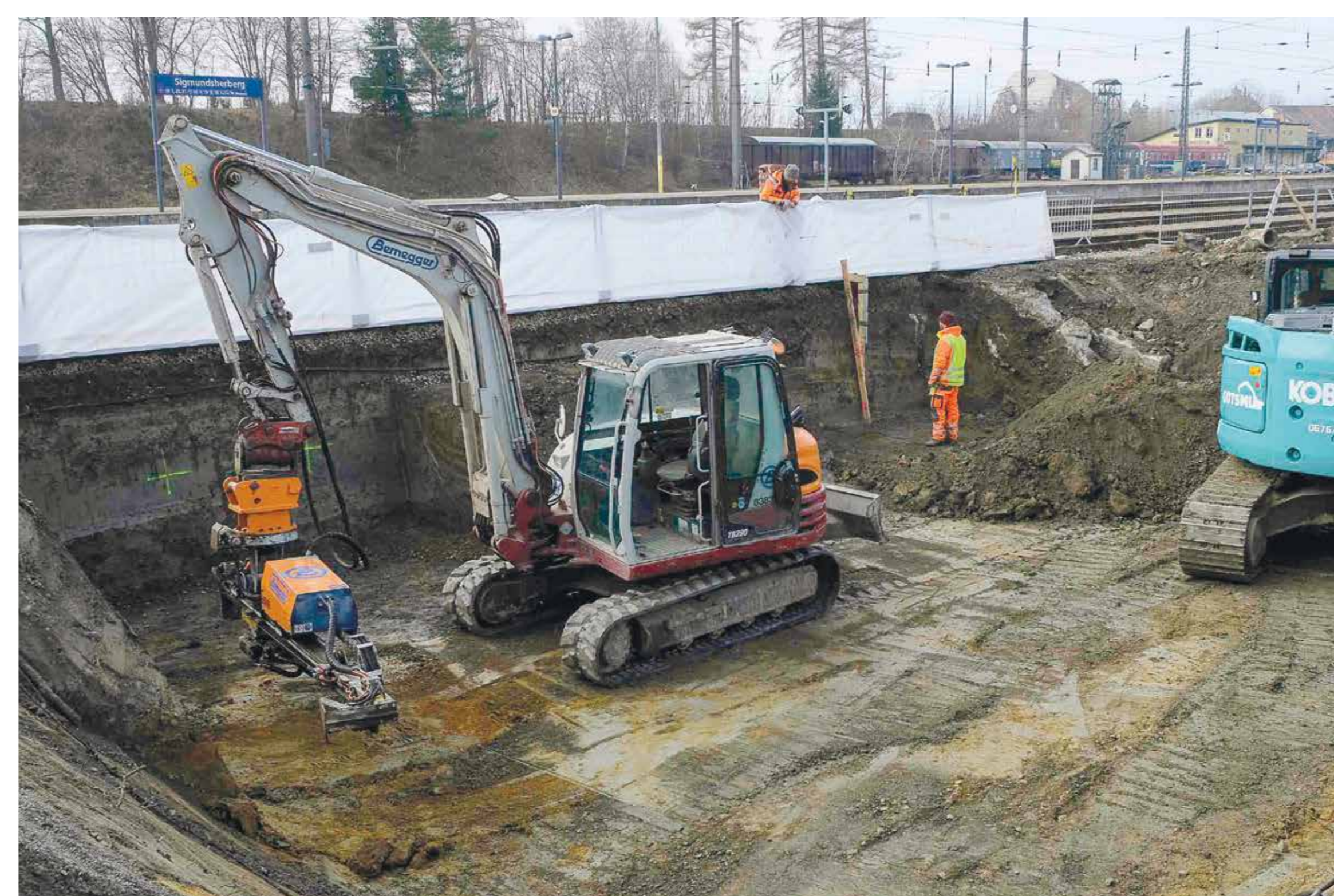
Die Bauarbeiten am Bahnhof Sigmundsherberg sind im Februar 2024 angelaufen.
