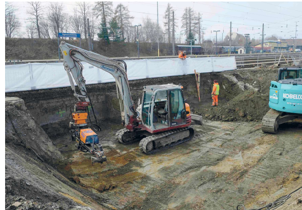
Die Bauarbeiten am Bahnhof Sigmundsherberg sind im Februar 2024 angelaufen.
