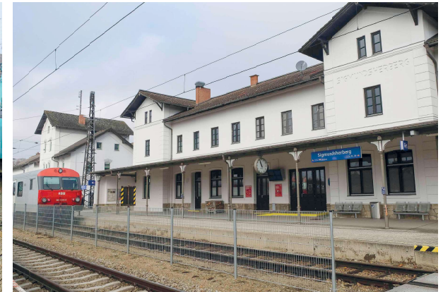
Die Arbeiten finden unter laufendem Betrieb statt.
