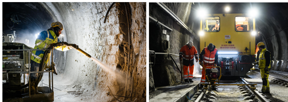
Arbeiten im Tauerntunnel im Frühjahr 2023
