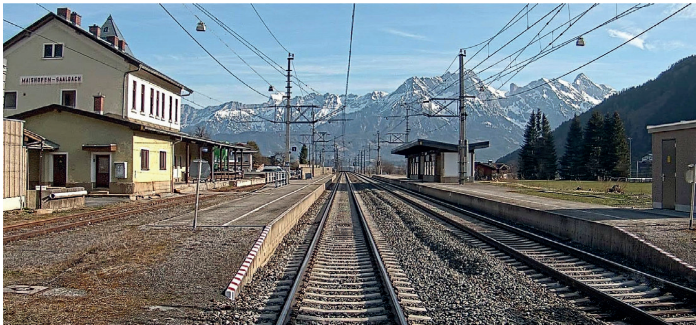
Anstelle der bestehenden Anlagen bekommt Maishofen-Saalbach eine neue, modernen Haltestelle
