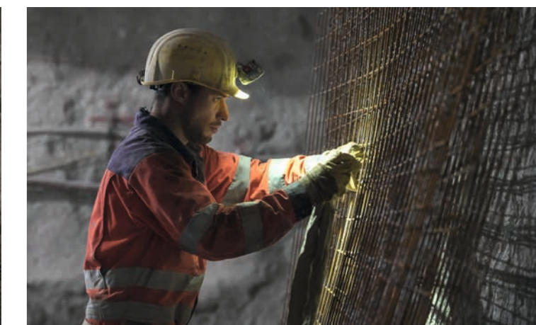
Einbau Baustahlgitter
