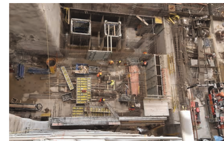
Betonbau Saugrohr und Schützenbereich (Kaverne)
