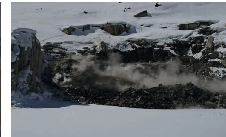
Sprengung für das Ein-/Auslaufbauwerk Tauernmoos
