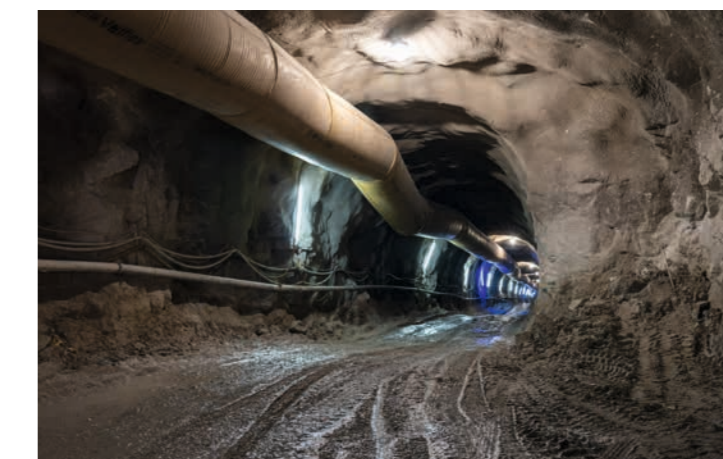
Zugangsstollen zur Kraftwerkskaverne
