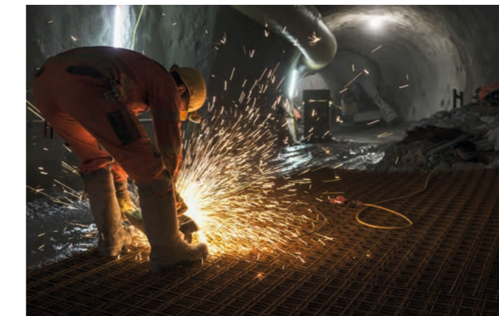
Mineur auf der Tunnelbaustelle
